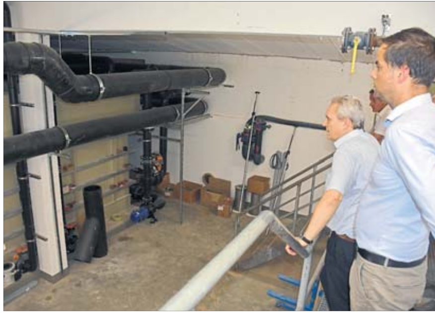
Im Technikraum ist noch nichts erneuert.
